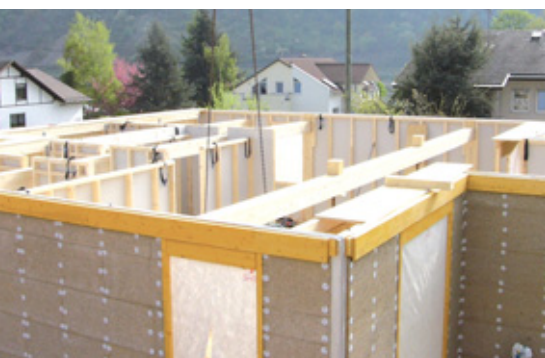
In diese Holzkonstruktion lassen sich dicht gepresste Strohballen als Dämmstoff einbauen.
