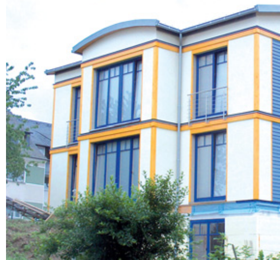
Dieses von der UmweltBank finanzierte Strohballenhaus wurde mit dem rheinland-pfälzischen Umweltpreis ausgezeichnet.
