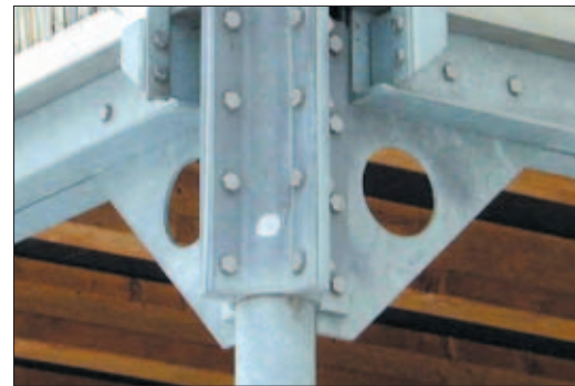
Auch im Detail durchdacht: Neue Balkone, wärmebrückenfrei vor die sanierte Fassade gestellt.
