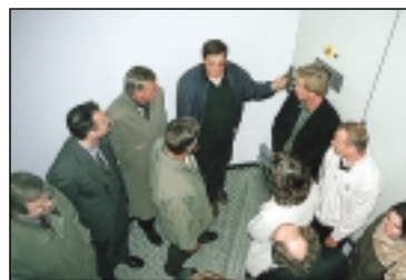
Teilnehmer der Sitzung bei der Besichtigung der Technik im Inneren einer Windkraftanlage vom Typ Nordex N-60
