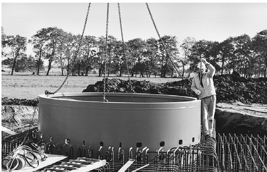
Voll im Plan: Für den Windpark Weenermoor sind alle Fundamente gesetzt, die ersten Anlagen stehen bereits.
