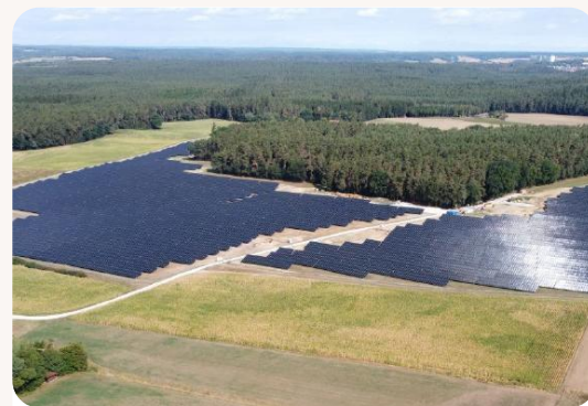
PV-Speicher-Kombination Regenstauf (Bayern)
