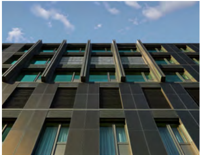
Die gewonnene Solarenergie aus der Fassade deckt den Strombedarf weitgehend.
