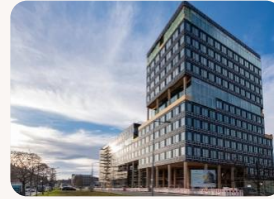
UmweltHaus: Bau, Einzug & Betrieb
