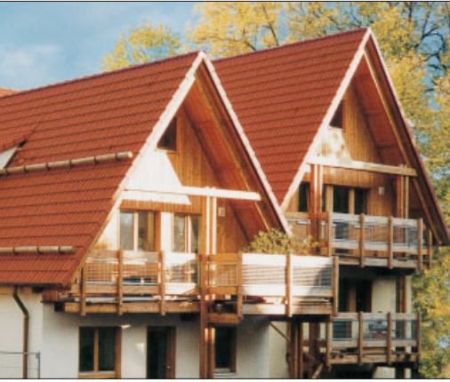
Das altengerechte Mehrfamilienhaus im süddeutschen Balingen verbindet ökologisches Bauen mit sozialem Rückhalt.
