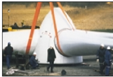
Der Windpark Scheddebrock entsteht Zug um Zug.
