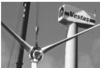
In Apensen kommen Vestas-Anlagen zum Einsatz. Das dänische Unternehmen baut seit 1979 Windkraftanlagen und ist weltweit Marktführer.
