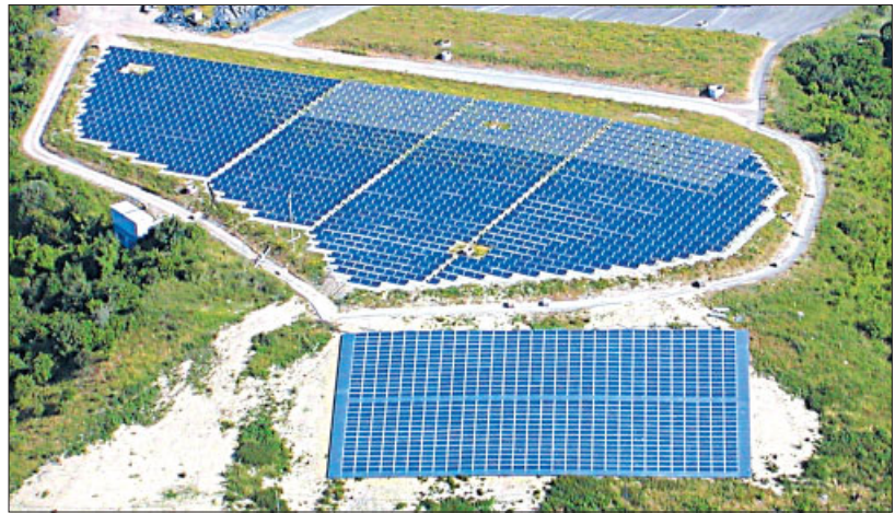
Luftbild der Anlage
