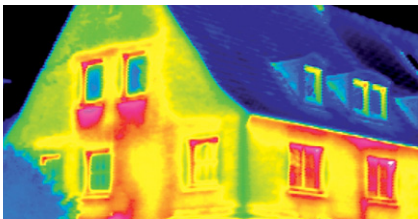
Ein Wärmebild zeigt auf, wo Energie verloren geht und welche Sanierungsmaßnahmen sinnvoll sind. Die UmweltBank unterstützt energiebewusste Bauherren mit günstigen Förderdarlehen.
