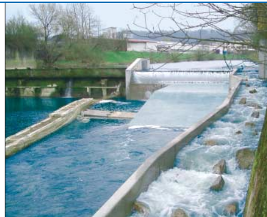
Das Bürger-Wasserkraftwerk Eberkraft produziert seit Anfang April umweltfreundlichen Strom. Die Anlage in Ebersbach an der Fils, zwischen Stuttgart und Ulm gelegen, wurde in ein bestehendes Wehr integriert. Neu gebaut wurde eine Fischtreppe.
